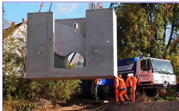
Selbststeuernde Drosselblende
