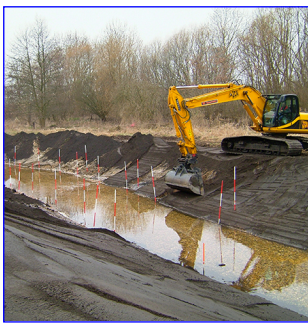
Böschungsabflachung
