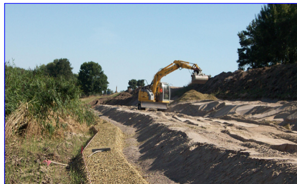
Einbau Stütz- und Filterkies
