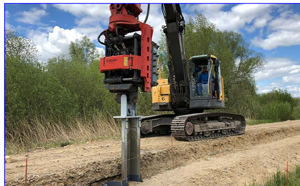
Einbringarbeiten Kunststoffspundwand (Dichtwand)
