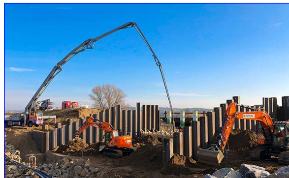
Betonage des Fachbaums
