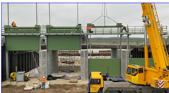
Montage der Ausrüstung
