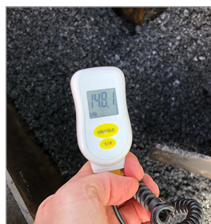
Kontrolle der Mischguttemperatur
