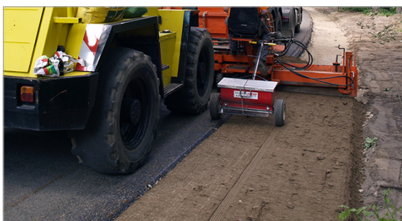
Einbau des Banketts
