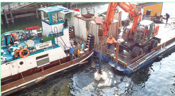
Tiefenräumung in Wasserstraßen
