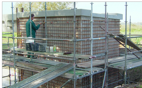
Bewehrung der Vorstattschale
