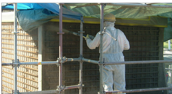
Auftrag des Spritzbetons
