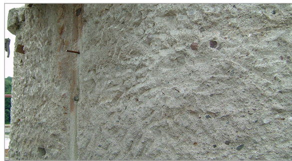
Abtrag des Altbetons
