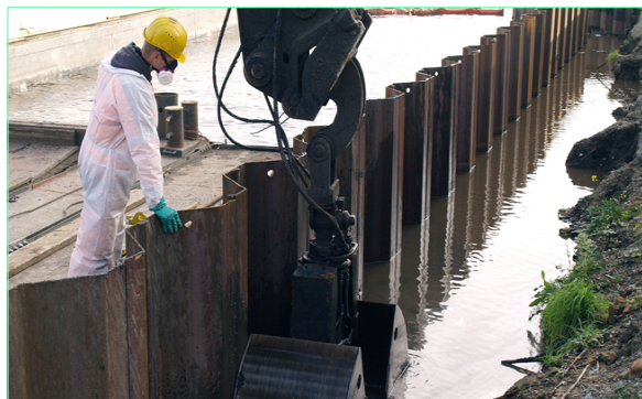
Baggerung belasteter Sedimente
