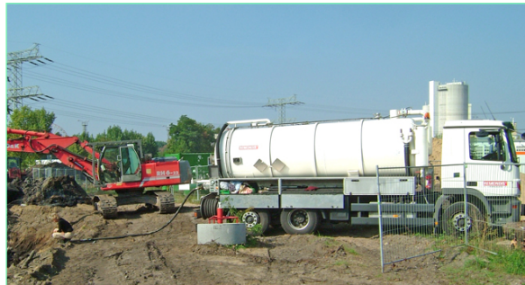
Absaugen belasteter Sedimente
