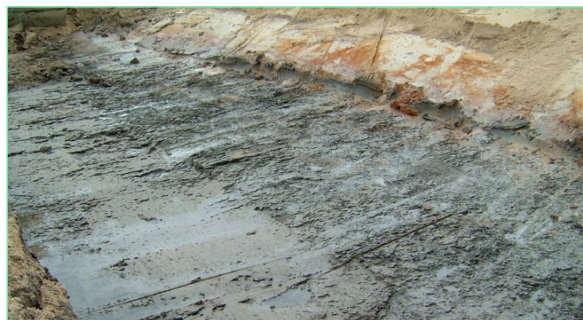
Erdschichtweiser Abtrag
